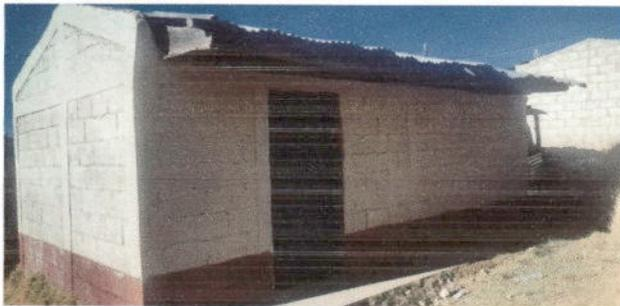
FOTO 3 Bodega sustitucion de lamina, techo y repello de pared
