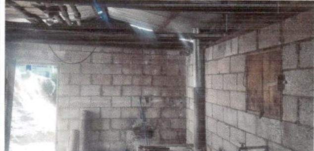
FOTO 4. Cocina sustitucion de lamina, techo ventana y Repello de pared.
